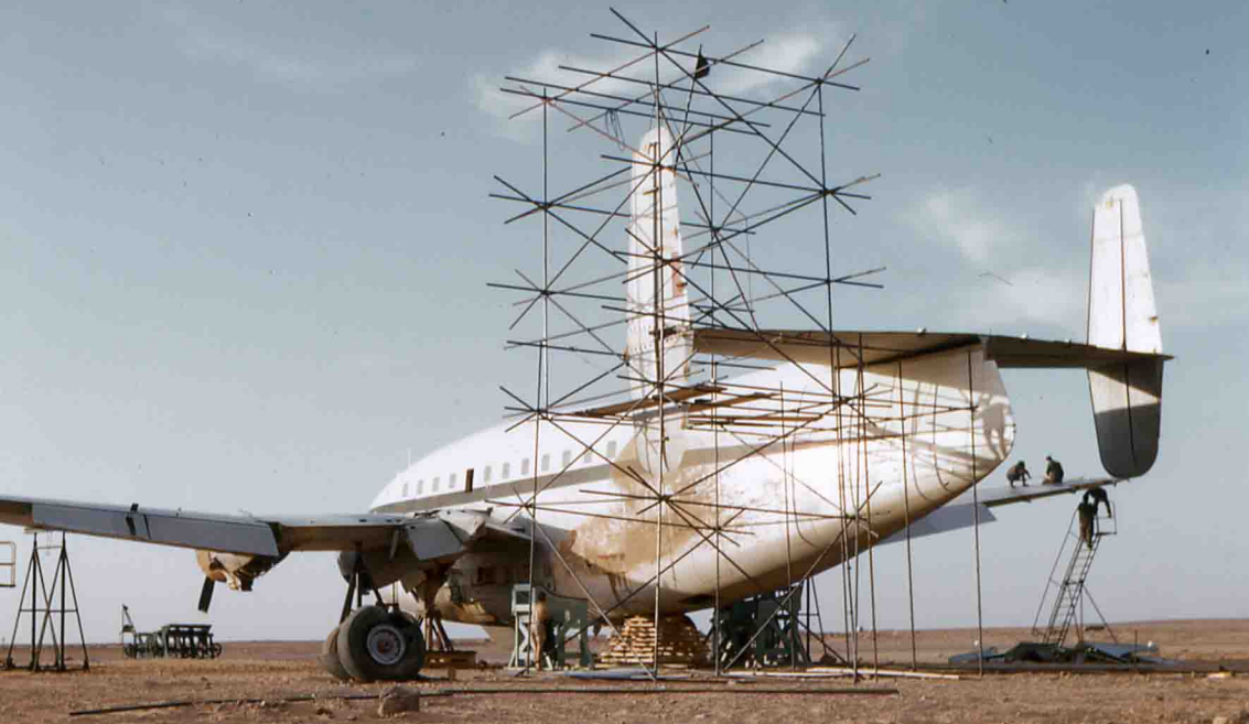
Le chantier de démembrement du Breguet 761s Deux-Ponts F-RAPA à Reggan
